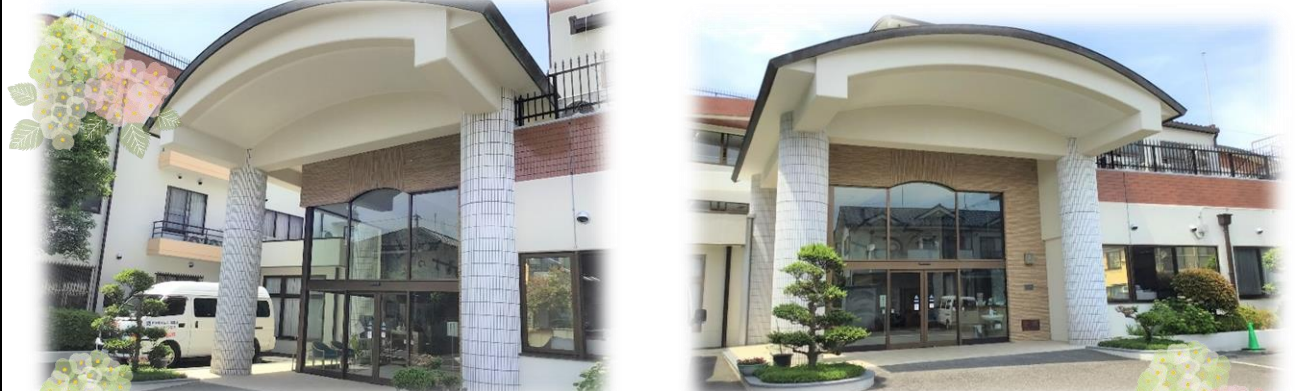
外壁の工事が完了しました！！
